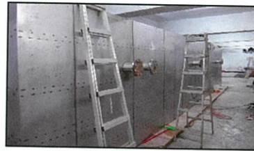
儲冰槽現場組裝施作
