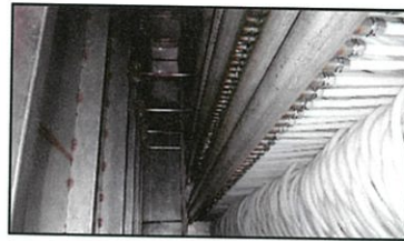
儲冰槽內部維修通道
