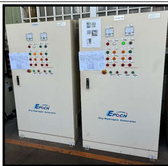
氬氧機焊接照片
